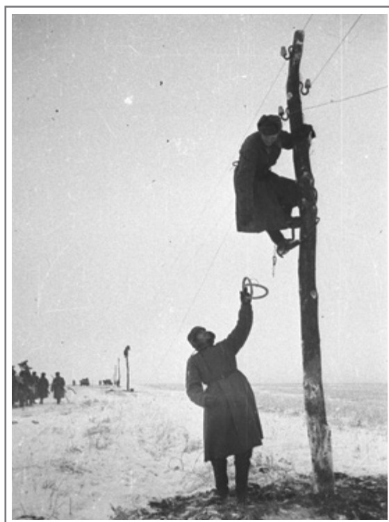
Советские связисты прокладывают телефонную линию в районе Сталинграда.
